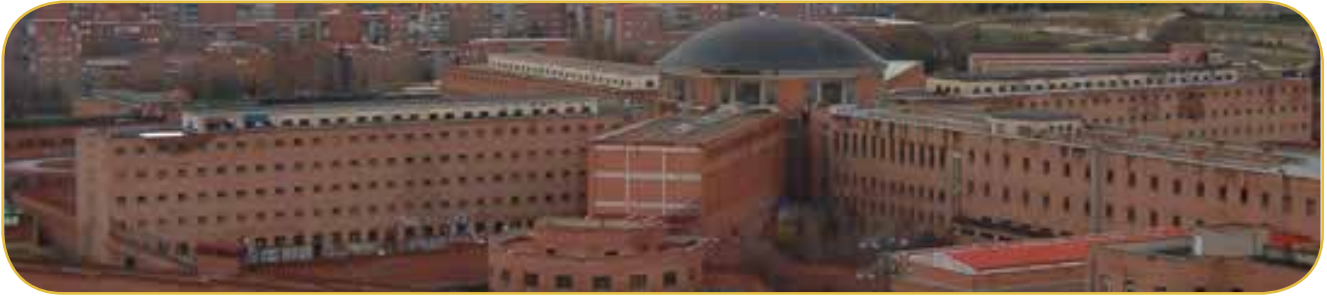
Non-conforme aux critères posés par la loi pénitentiaire
